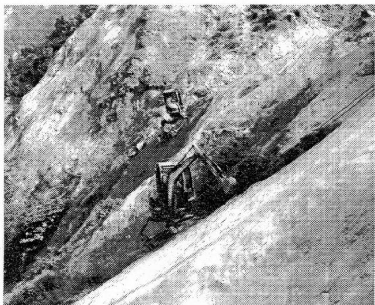
楢木地区地すべり現場での作業の様子
