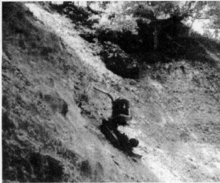
リモコンによる無人化施工する妙高関山地区の現場
