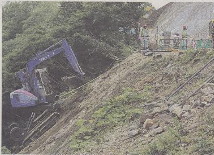
ワイヤでつるしたバックホーに乗り、急斜面を探索する土木作業員。慎重で根気強い作業を強いられている
