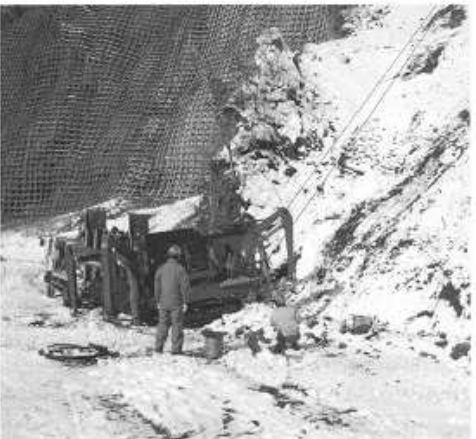
写真9 現場での斜面への乗り移り動作
