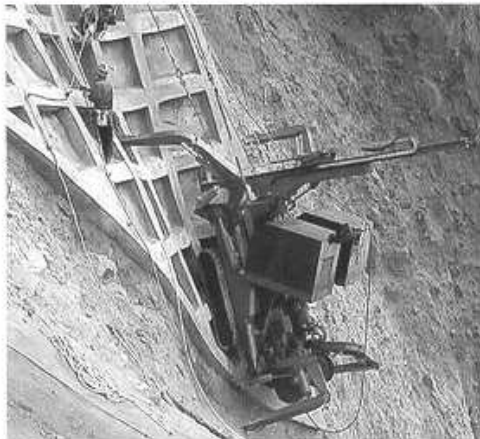
写真11 現場での掘削作業
