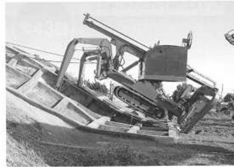
写真6 模擬法面での実験
