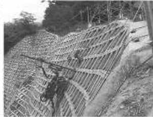
写真1 法面の工事現場の例
