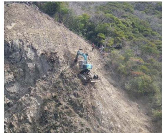
写真-2 掘削状況（RCM工法）
