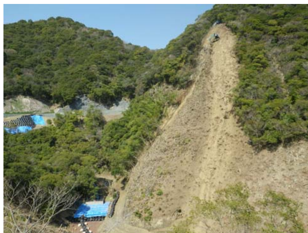
写真-1 左岸掘削全景
