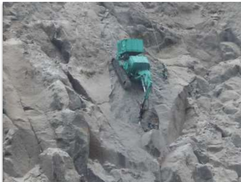
【高所岩盤掘削機による施工状況】
