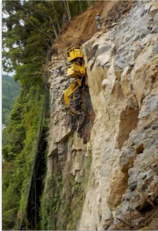
高所岩盤掘削機仕様
