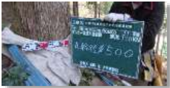
斜面上部生立木の根株を用いたアンカー（アンカー引張試験）
