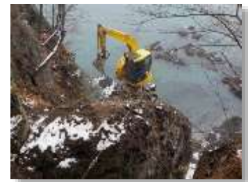
軟岩Ⅰ・Ⅱと硬岩の切取及びロックネットの撤去
