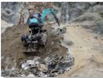
既設モルタル取り壊し
