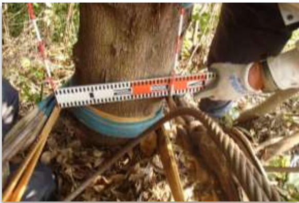
アンカー選定作業(生立木の根株測定)
