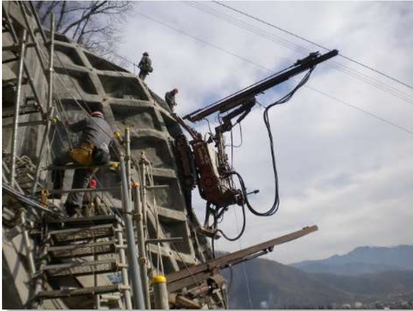
無足場削孔機（アンカーロックマシン）による削孔作業 【施工概略】
