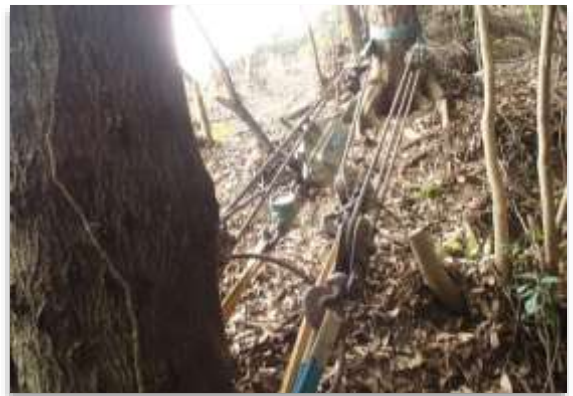
生立木使用のアンカー引張試験作業
