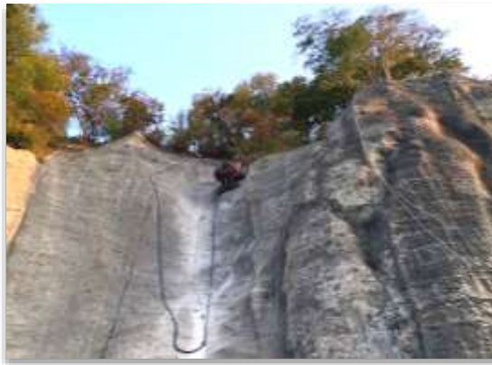
無足場削孔機(アンカーロックマシン)
