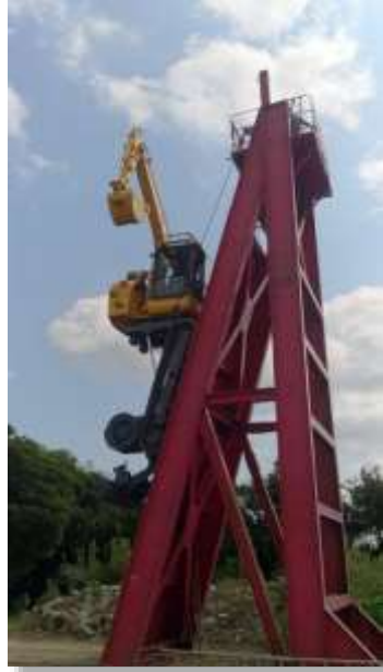
試験設備:クライミングタワー
