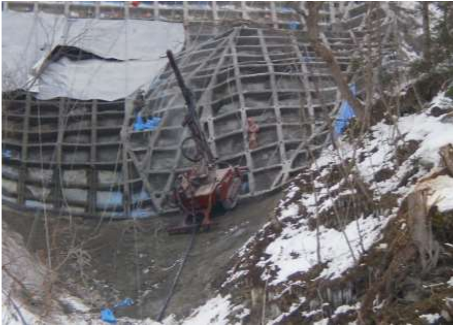
無足場削孔機（アンカーロックマシーン）
